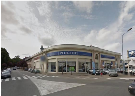
LOUVIERS, Garage automobile, 1932 (archi : RAVAZE Maurice-Jacques)
