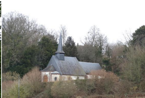
SAINT DENIS D'AUGERONS, Eglise Saint-Denis, 1946
